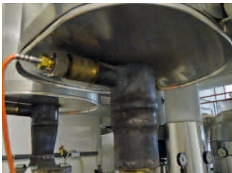
Ein angepasster Fühler machte den Austausch ohne aufwändige Umbauten möglich.
