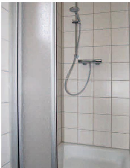
Die Sanitärräume wurden unter anderem mit Duschen ausgestattet, die eine dreiteilige Schiebetür sowie eine moderne Selbstschlussarmatur aufweisen.
