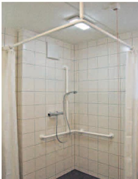
Im Erdgeschoss hat man jeweils eine barrierefreie Dusche vorgesehen, die ebenfalls mit Benkiser Selbstschlussarmaturen ausgestattet sind.
