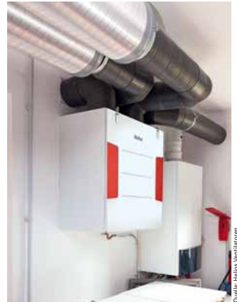
Meist in den Kellerräumen installiert, benötigen die zentralen KWL-Geräte kaum kostbare Wohnfläche.
