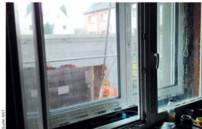
Das neue Fenster sitzt direkt vor dem alten, das am Ende von innen entfernt wird.
