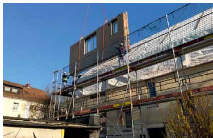
Hameln, Quartier Kuckuck: Das erste Fassadenmodul wird montiert.
