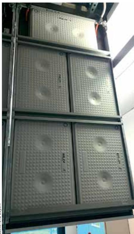
Abgeklappte Kühldecken mit PCM-Modulen im Energy Efficiency Center. Über die Metallkassetten wird eine gute thermische Ankopplung des PCM an den Raum erreicht. Die Belegungsdichte beträgt rund 5 kg PCM pro m<sup>2</sup> Bürofläche.
