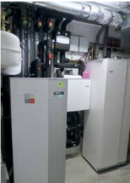
5 – Die Nibe-Wärmepumpeneinheit im Vierbrockhaus besteht aus der Sole/Wasser-Wärmepumpe F1155-6, dem Brauchwasserspeicher VPB 300 und dem Passiv-Aktiv-Kühlmodul HPAC 40.
