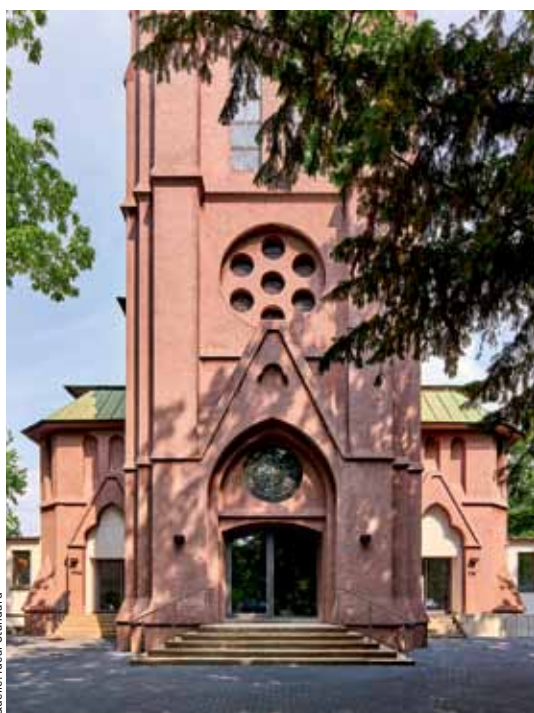
Turmfassade der umgebauten, ehemaligen Lutherkirche mit den Hauseingängen 116 und 116a
