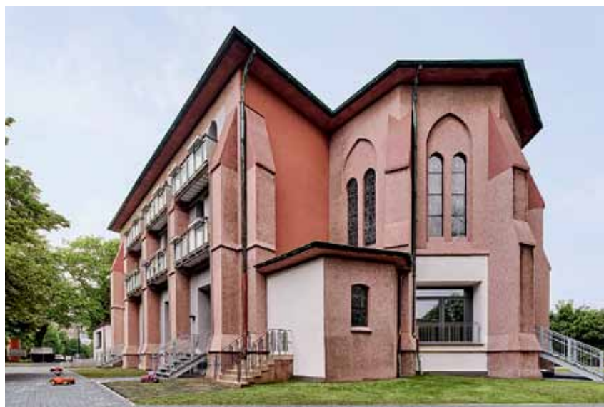
Haus-in-Haus-Konzept – Kindertagesstätte im Erdgeschoss und 14 Apartments in den beiden Obergeschossen
