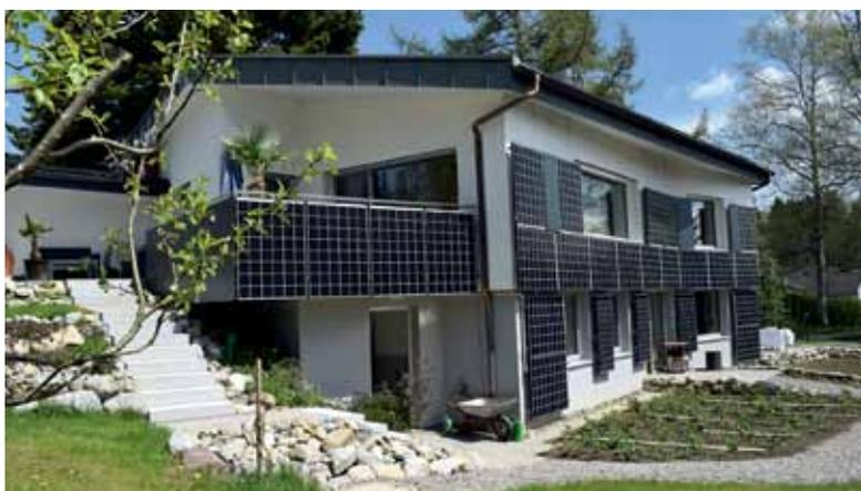
Auch an der Fassade wurden PV-Module angebracht. Sie liefern an sonnigen Wintertagen selbst dann Strom, wenn Schnee auf den Dachmodulen liegt. Die Gesamtleistung des Systems beträgt 32 kWp.
