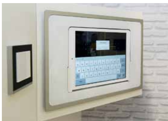
Kontrollierte Wohnraumlüftung mit Wärmeübertrager: Die Steuerung und Visualisierung findet über ein Tablet statt. Links befinden sich der Lichtvorhang und die Zentrale für die Einbruchmeldeanlage sowie die Alarmsignalisierung über die Blitzleuchte.
