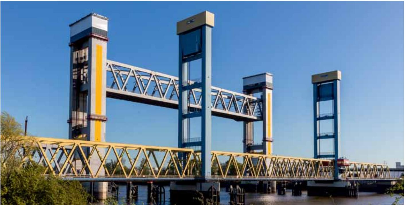
Bundesbau-Pilotprojekt iPAK5: Grundsanierung der 1972 erbauten Kattwykbrücke, einer Hubbrücke über die Süderelbe in Hamburg, inklusive Austausch der Hubtechnik und Erneuerung der EMSR mit Anbindung an den neuen Steuerstand
