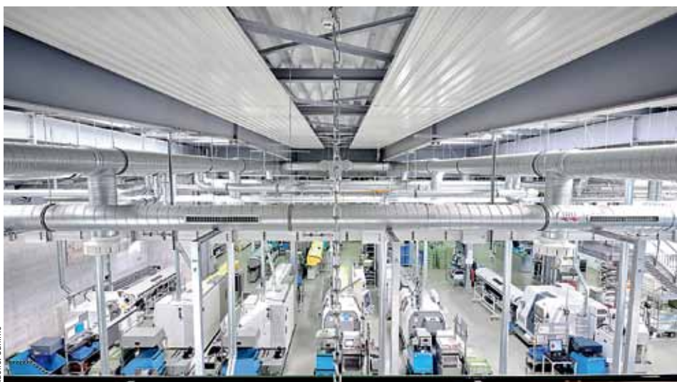
Sata Produktionshalle mit Sunline Deckenstrahlplatten
