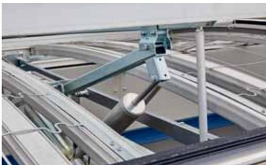
**DAS RAUCH- UND WÄRME-ABZUGSGERÄT SOWIE** der Linearantrieb sorgen für kontrollierte natürliche Lüftung und Sicherheit im Brandfall
