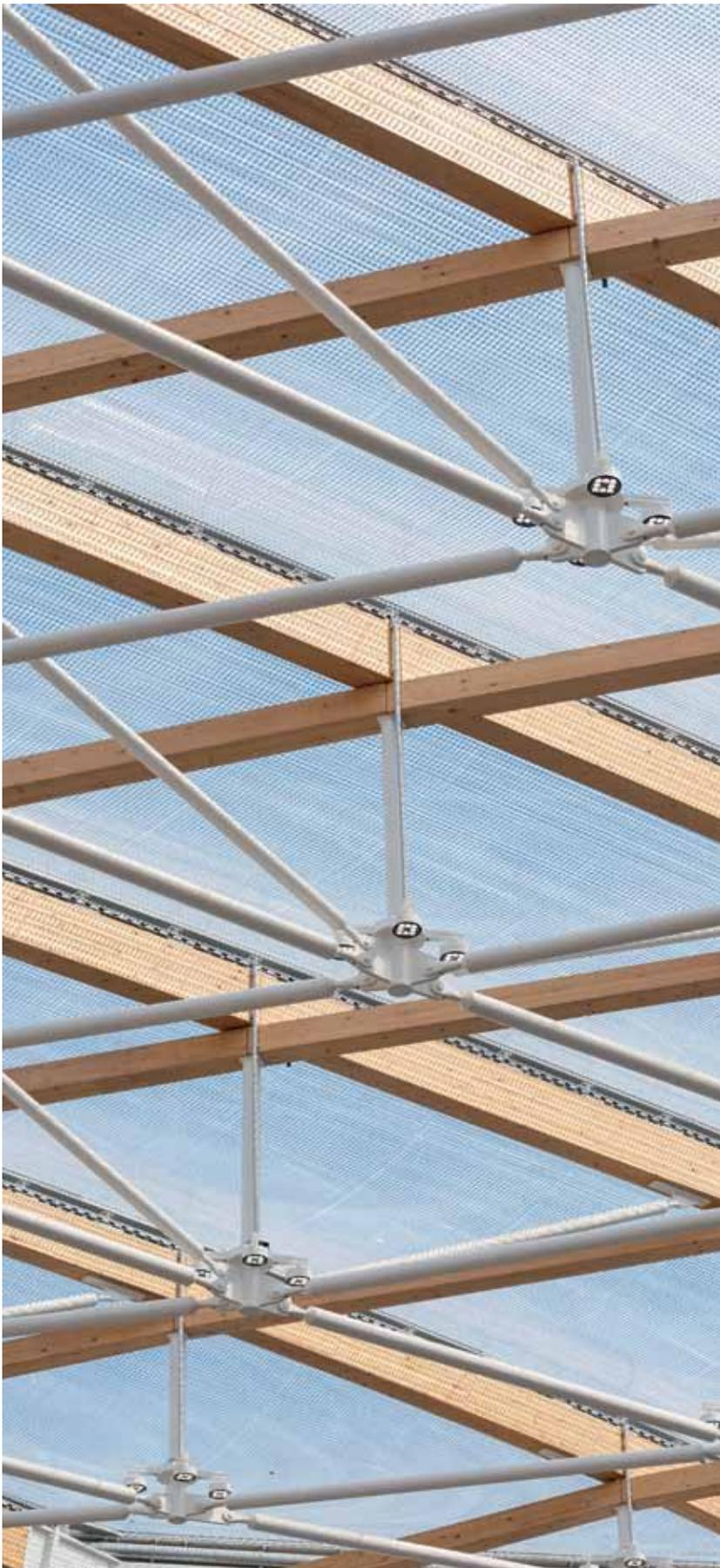
**DAS DACH** ist brandsicher konstruiert mit Folienkissen, die mit Holzleimbändern gestützt sind
