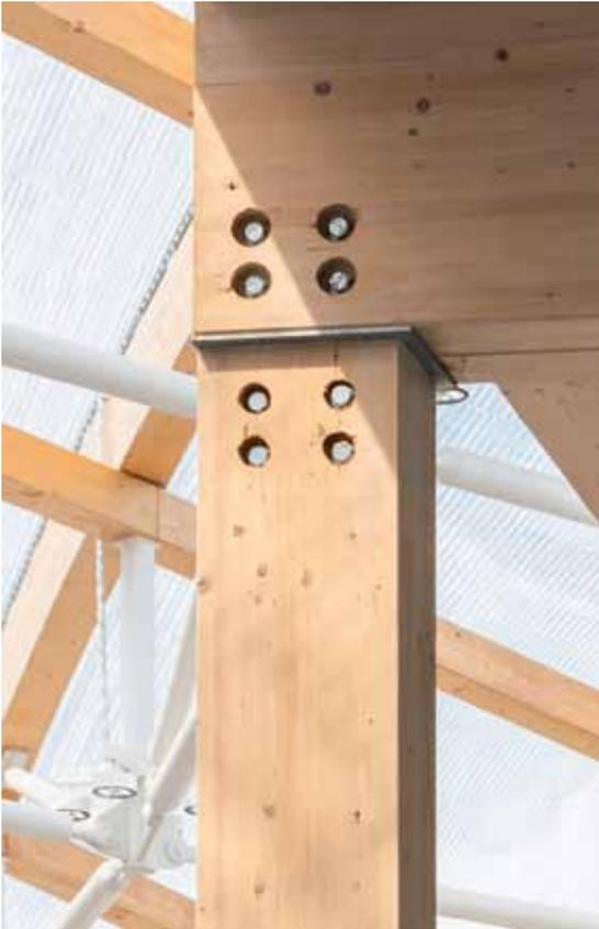
**BRANDSICHERE** Bauteilanschlüsse installiert
