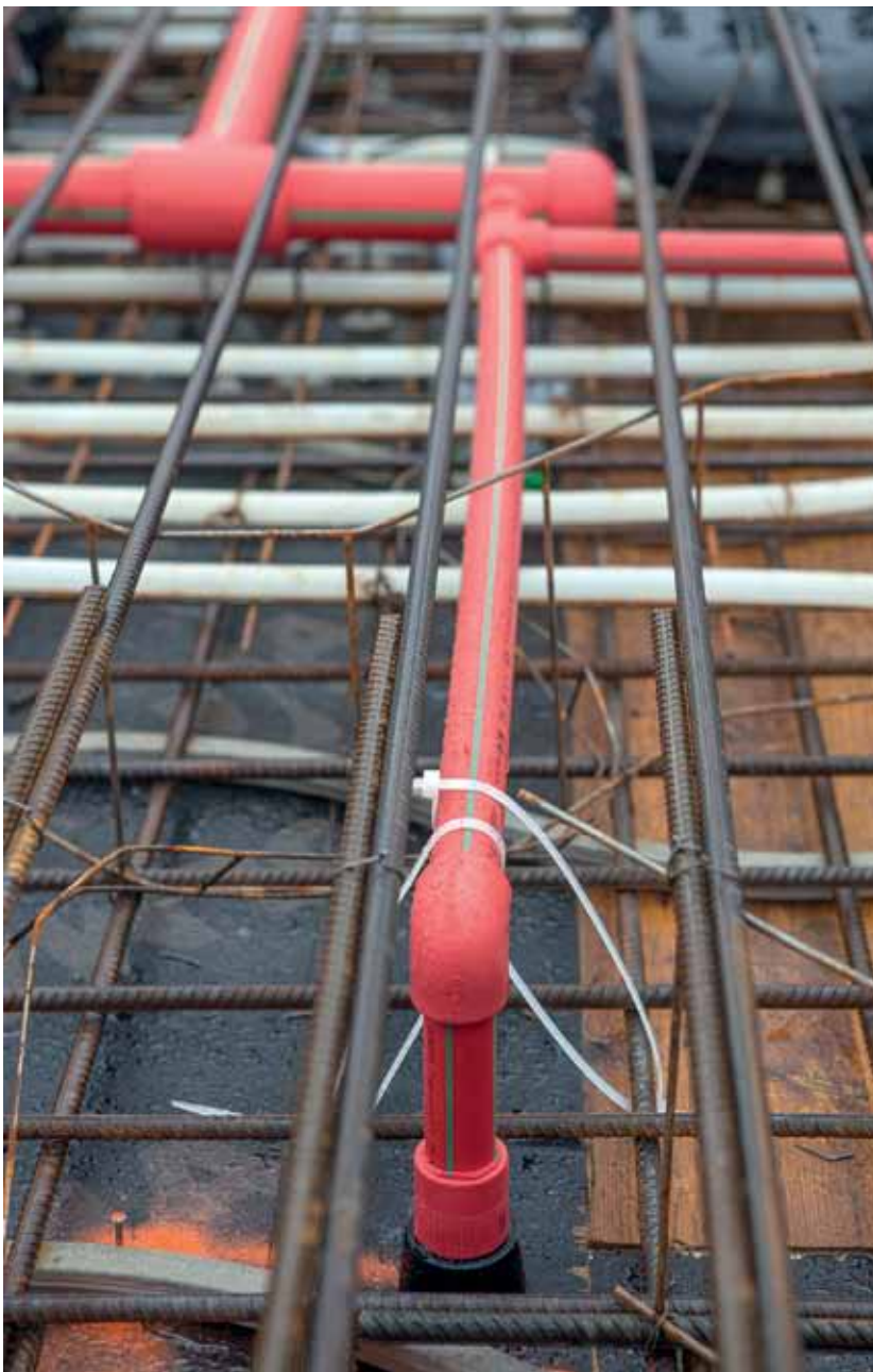
EINFACHER EINBAU direkt in den Beton trotz Hohlkörperdecken mit Luftkammern
